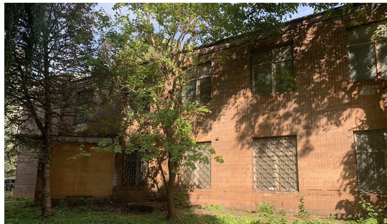
Будівля водогрязелікарні, 893,9 кв.м, вул. Теплична, 18
