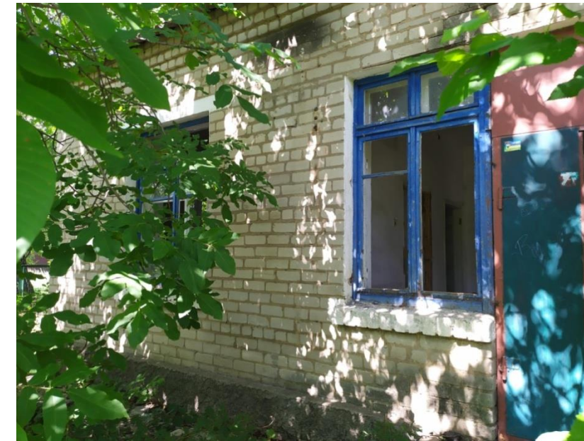
Будівля з підвалом, 116 кв.м, м. Вільнянськ
